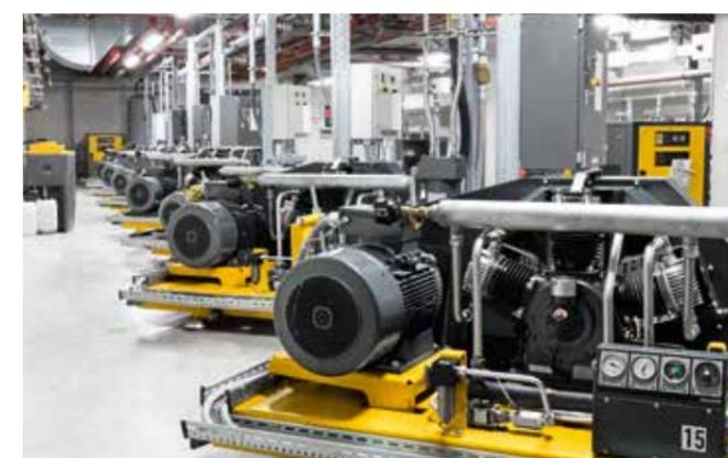
Photo du haut: la station de surpresseurs à vis 10 bar
